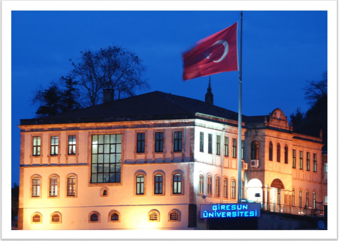
Giresun Üniversitesi Merkez Rektörlük Binası
